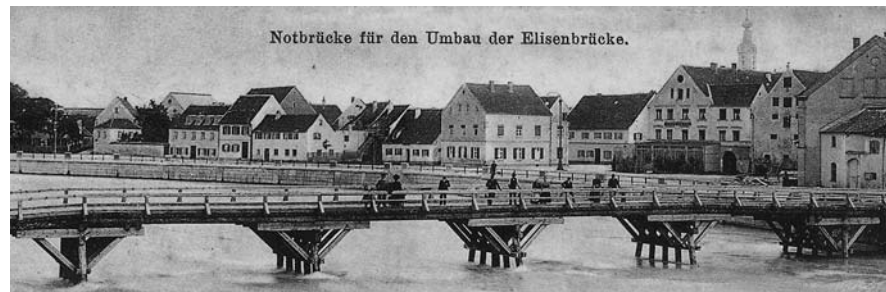
Abb. 87 (Kat. 92): Die 1906 errichtete Notbrücke unterhalb der Eisenbrücke.
