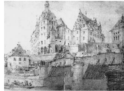
Abb. 62 (Kat. 66): Blick von der Insel auf die umgebaute Eisenbrücke mit der treppenförmigen Verbretterung des Geländers, 1856.
