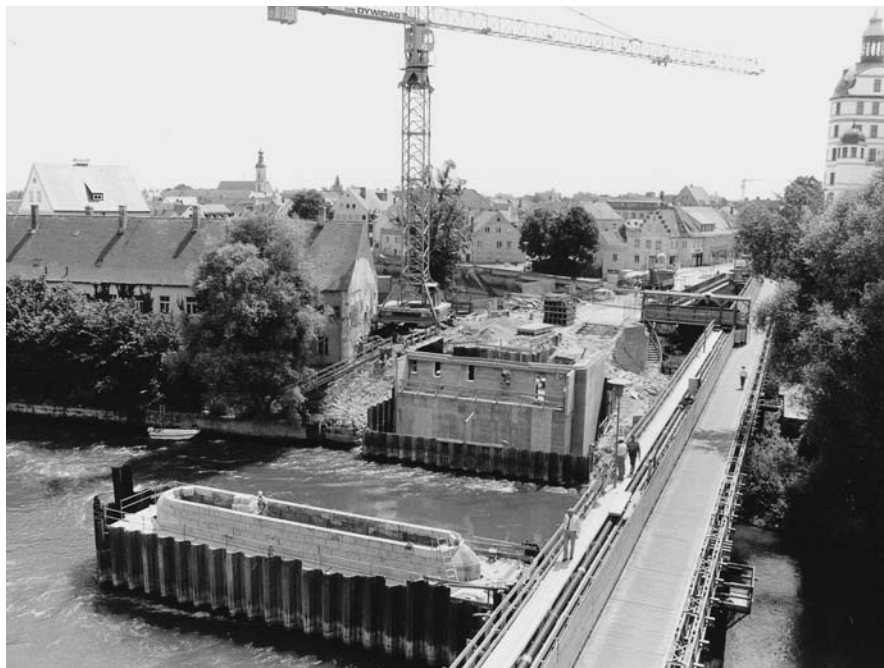
Abb. 103 (Kat. 108): Bauarbeiten an der heutigen Altwasserbrücke.
