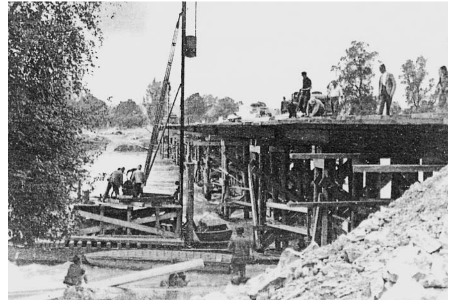
Abb. 96 (Kat. 101): Die Behelfsbrücke beim Ruderclub kurz vor der Fertigstellung, 1945.
