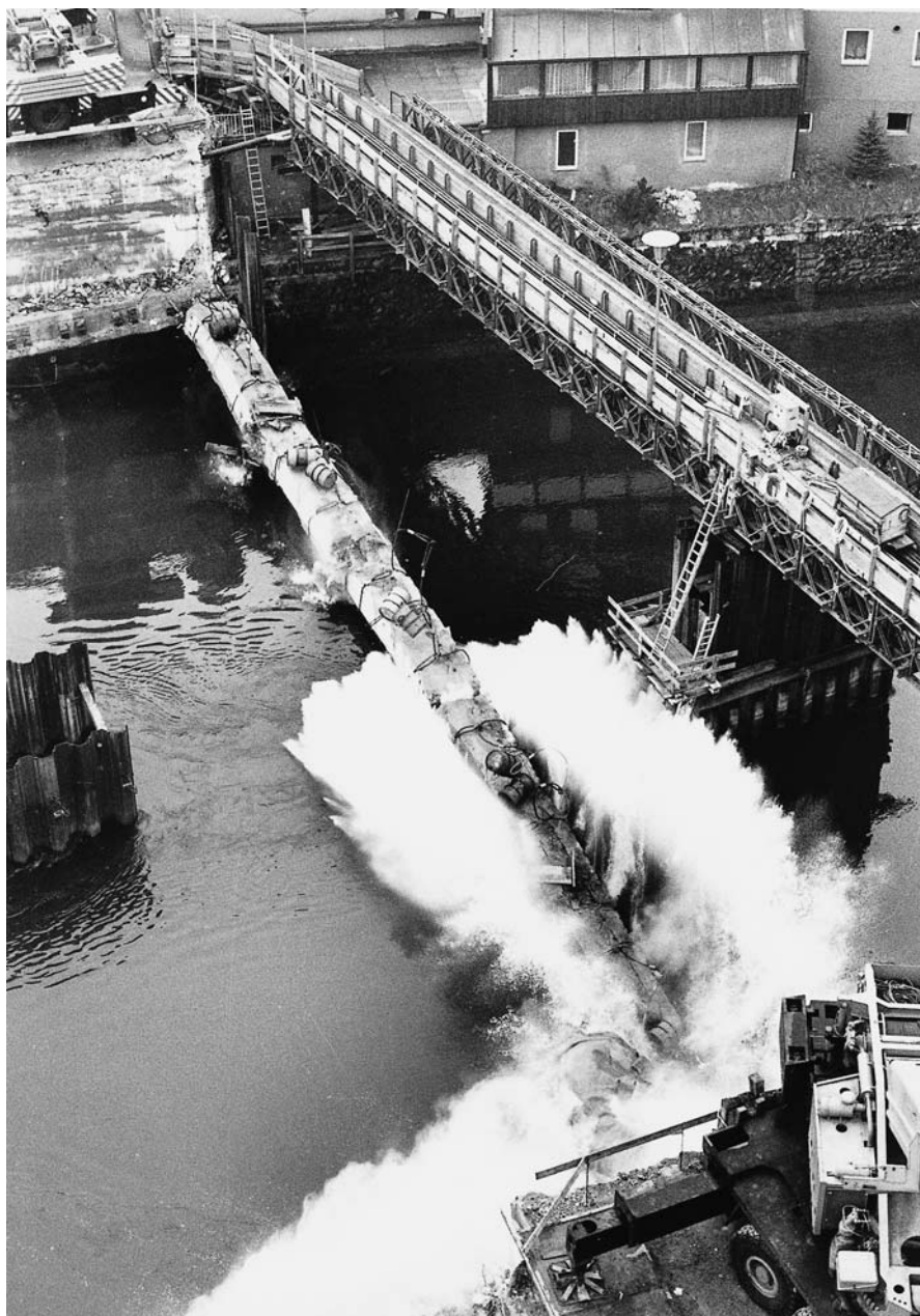
Abb. 101 (Kat. 106): Sprengung des letzten Betonbogens der Nachkriegsbrücke beim Neubau der vierten Elisenbrücke, Dezember 1988.
