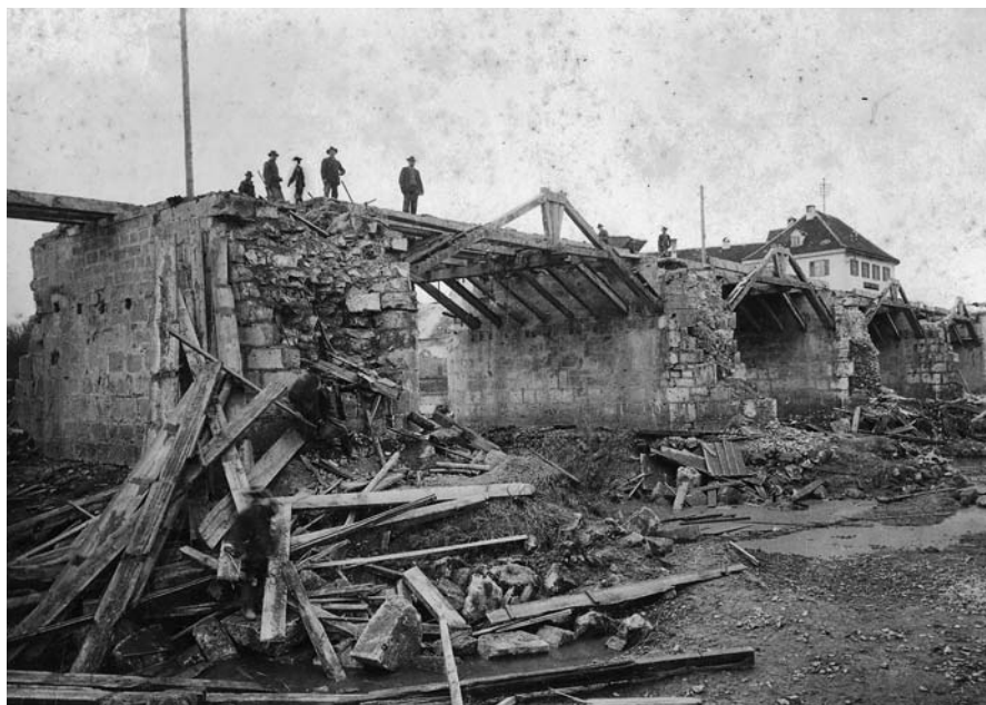
Abb. 79 (Kat. 84): Abbruch der Altwasserbrücke, Ende 1907.
