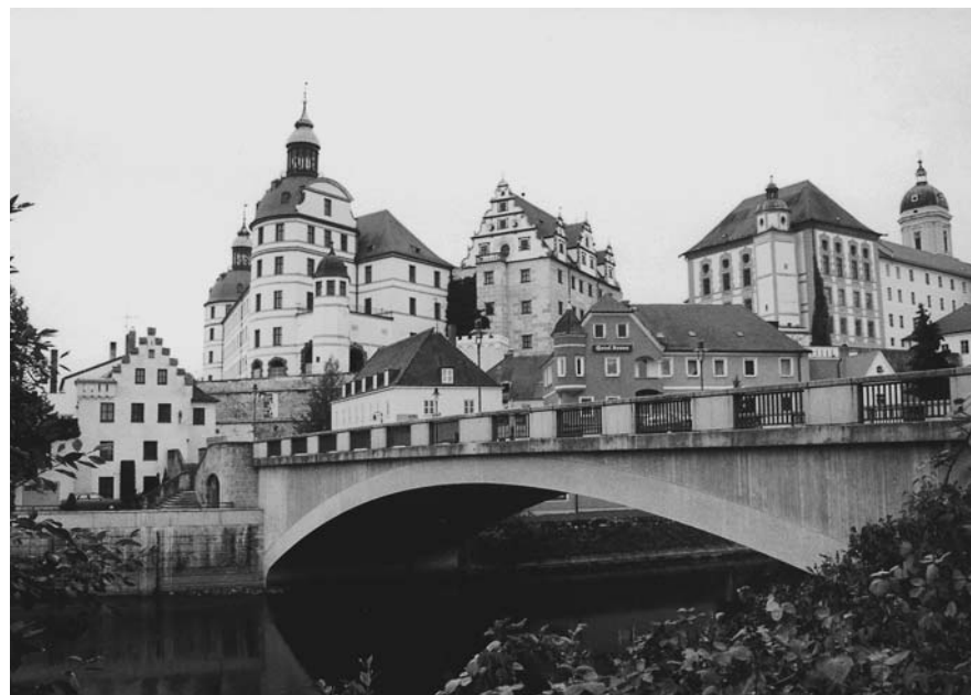
Abb. 106 (Kat. 111): Die heutige, vierte Elisenbrücke im November 2003.
