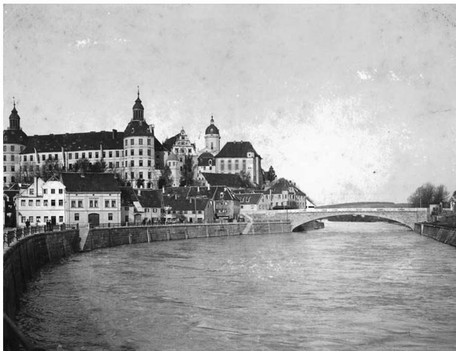
Abb. 91 (Kat. 96): Die formschöne zweite Elisenbrücke (Thiersch-Brücke) wird am 20. Dezember 1907 dem Verkehr übergeben.
