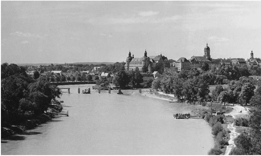
Abb. 95 (Kat. 100): Blick auf die Wagenfähre (Vordergrund) und die gerade im Bau befindliche Behelfsbrücke beim Ruderclub, 1945 (Teilansicht).
