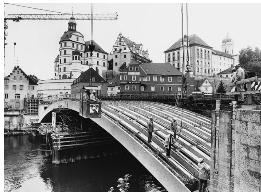
Abb. 102 (Kat. 107): Fertigstellung der sieben Betonbögen an der heutigen, vierten Elisenbrücke.
