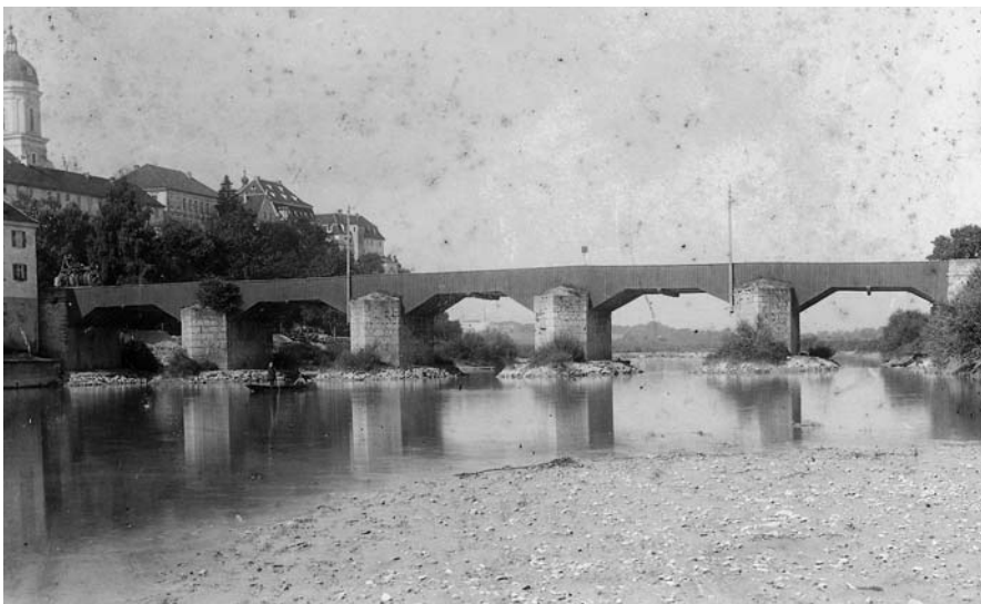
Abb. 77 (Kat. 82): Altwasserbrücke von unterstrom, um 1900.
