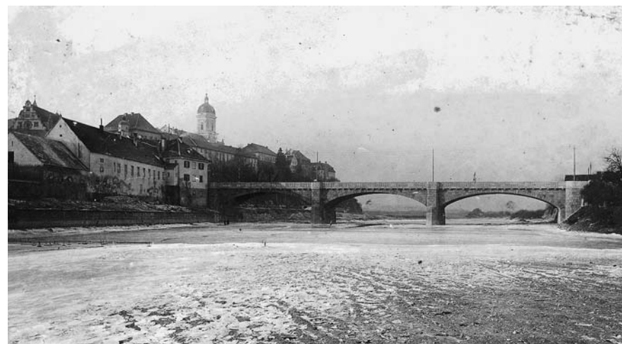
Abb. 92 (Kat. 97): Am 9. September 1908 erfolgt die Verkehrsfreigabe der neuen Altwasserbrücke (Thiersch-Brücke). Im Gegensatz zu ihrem Vorgängerbau besitzt sie nur mehr zwei Steinpfeiler.
