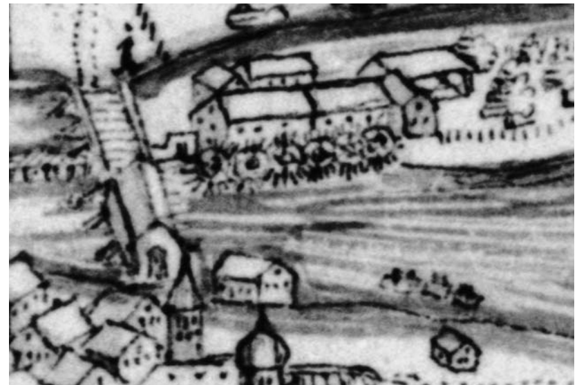
Abb. 6 (Kat. 11): Torhaus von Süden, 1612/1756 (Teilansicht).
