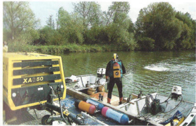
Abb. 14: Stepperg, Pfeiler 4. Entnahme von Holzproben mittels einer pneumatischen Unterwassersäge. Der Luftschlauch der Säge führt vom Baukompressor über den Sicherungstaucher zum Arbeitstaucher am Flußgrund.
