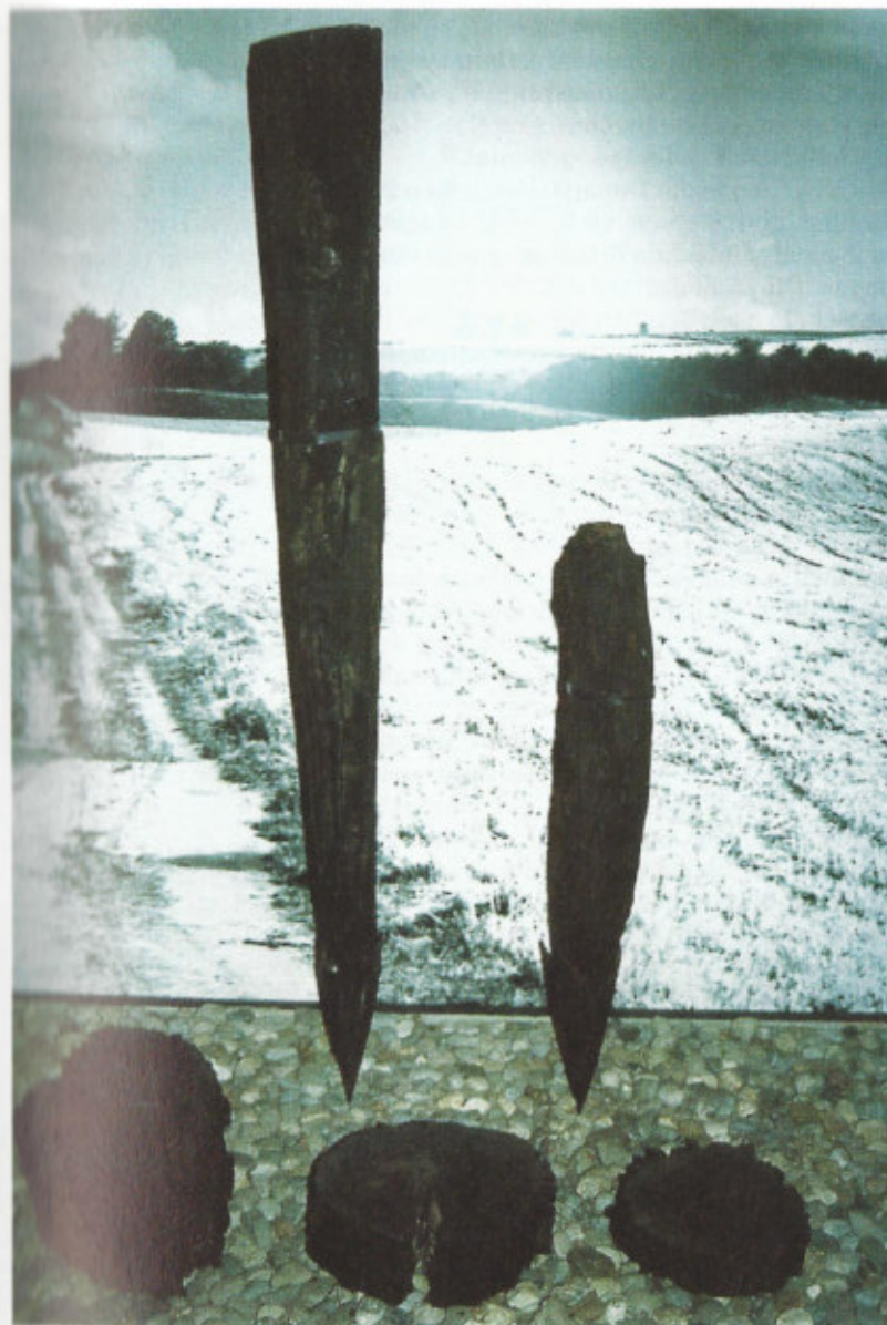
Abb. 25: Mit Pfahlschuhen bewehrte Eichenpfähle der Stepperger Römerbrücke (Schloßmuseum Neuburg).
