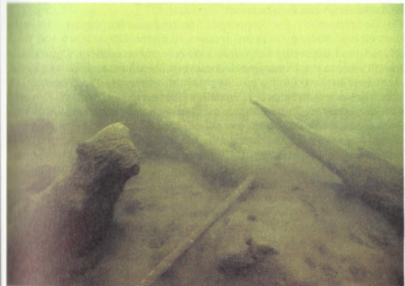
Abb. 22: Unterwasseraufnahmen von Pfeiler 6. Oben: Balkenwand L29 und der anliegende Pfahl P4. Unten: spitz aberodierte Balken eines Quertiegels.
