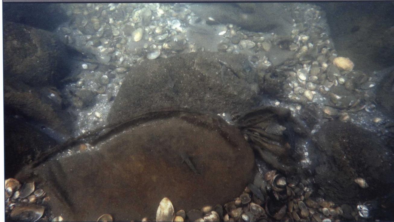
Abb. 3: Die im Vorjahr eingebrachten Sandsäcke in Schnitt A zeigen bereits eine schützende Sedimentauflage
