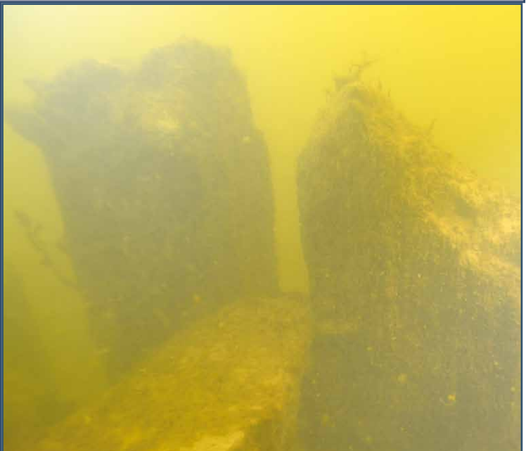
Abb. 3: Holzverbindung an Palisadenpfosten in 3 m Tiefe
