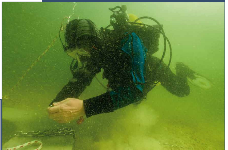
Abb. 4: Taucher bei der Installation der Bojenkette am Seegrund
